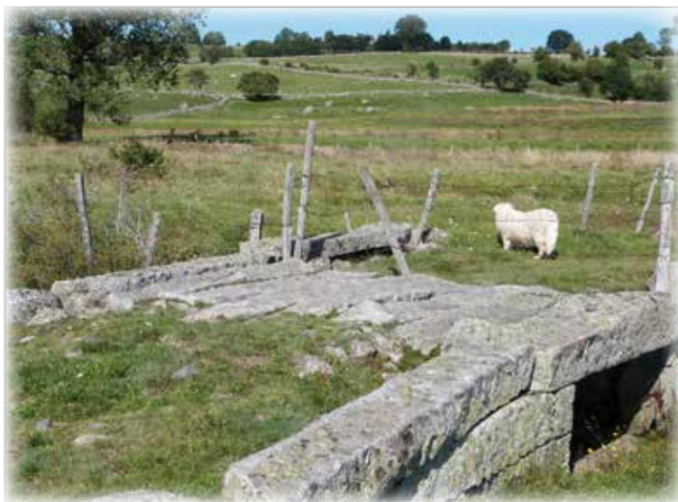
18. Le ponceau sur le bief du moulin
