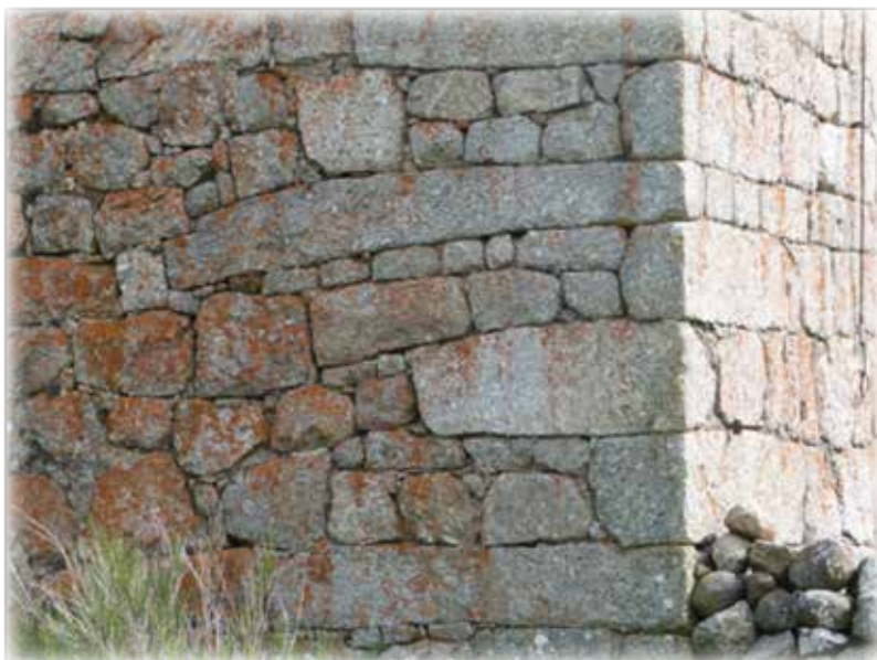
14. Pierres de chaînage à La Brugère
